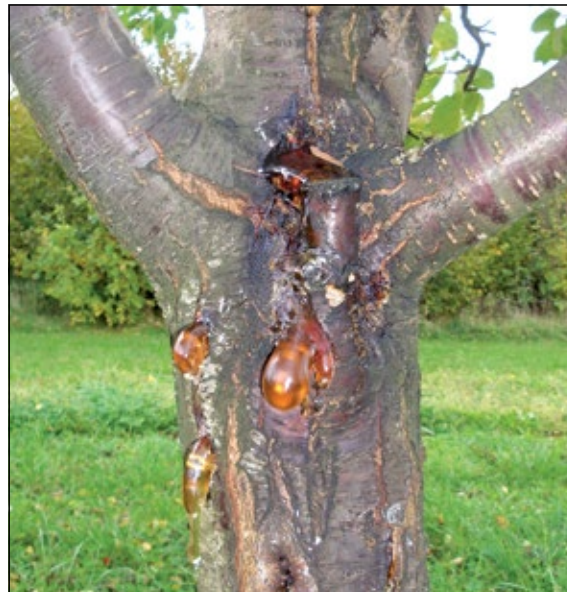
Kauleņkoku bakteriālā vēža bojāts stumbrs
